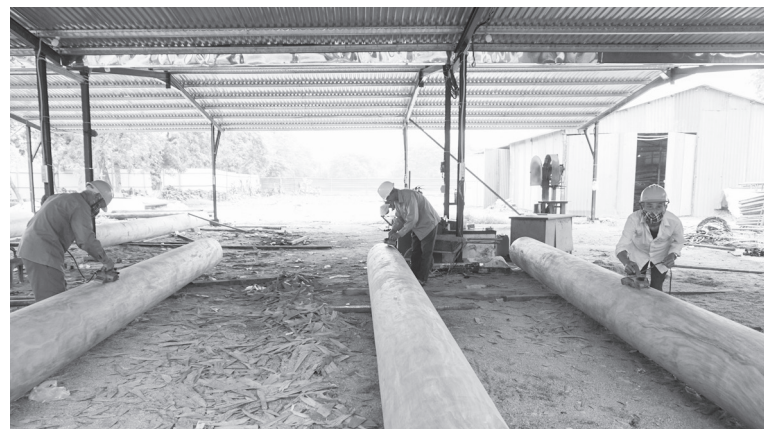
Thợ thi công cấu kiện gỗ để phục vụ tu bổ công trình di tích tại khu di sản Huế
